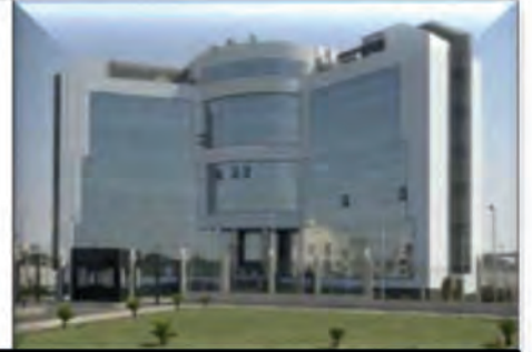
مبنى سلطة الطيران المدني وإدارة الازمات (بالقاهرة)
